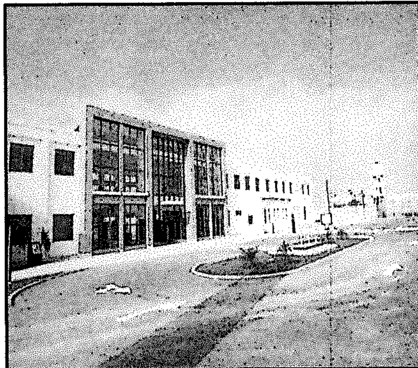
Vista lateral izquierda – construcción japonesa
